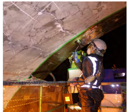
▲繊維シート接着工
