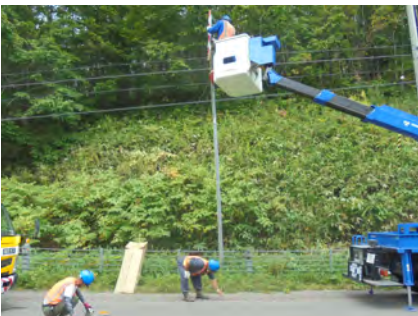
▲矢羽根交換状況
