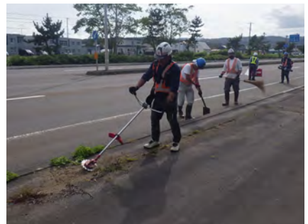
▲縁石除草状況
