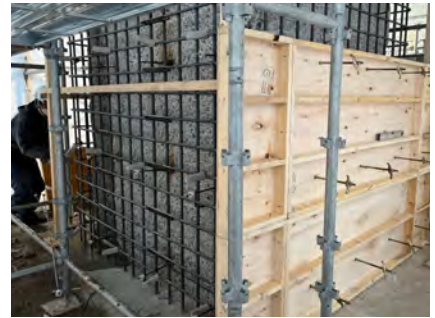
▲ 橋脚巻立て工
