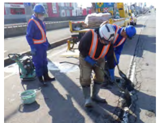
▲路面補修②
