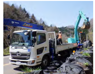
▲大型土のう入れ替え
