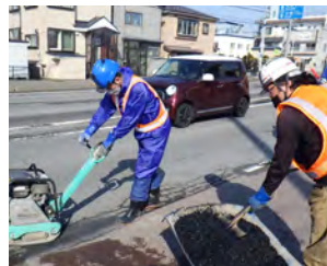
▲路面補修①
