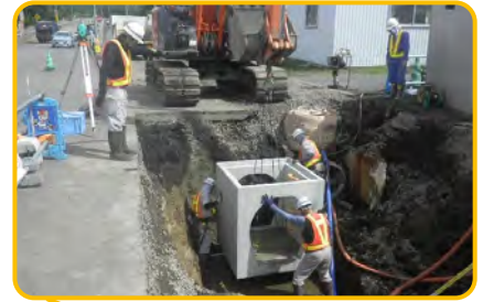
● 集水樹設置状況
