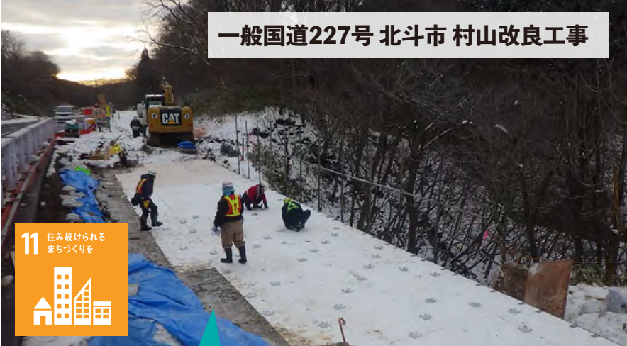
● EPSブロック用壁面材設置
