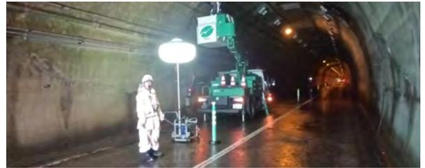
本工事は、函館市古部町の国道278号、滝の沢トンネルでトンネル補修工事を行っています。昭和40年頃に作られ、60年近く立ち老朽化に伴う漏水やひび割れが確認されており、これらの補修工事を行っています。9月上旬から施工開始し、翌年2月下旬に施工完了予定です。工事中は片側交互通行等による交通規制を行っています。
