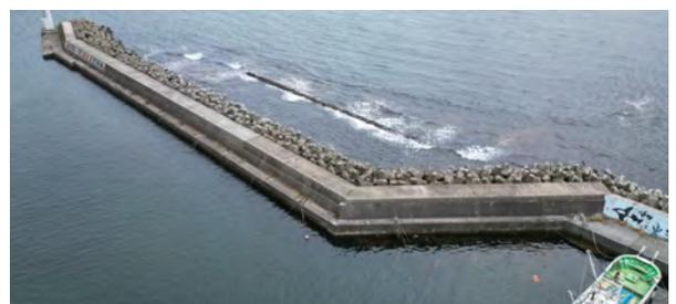
本工事は、北斗市にある当別漁港、木古内町にある釜谷漁港と札苅漁港にて工事を行っています。当別漁港の南防波堤68m・札苅漁港の南防波堤20.2m、合わせて88.2mと、当別漁港の船揚場46.6m・釜谷漁港の船揚場20.1m、合わせて66.7mの機能保全工事を行っています。9月中旬から当別漁港の防波堤68m・船揚場46.6mの施工を開始し、3月上旬に施工完了予定です。工事中の水難事故等に十分注意し、安全に作業を行って参ります。
